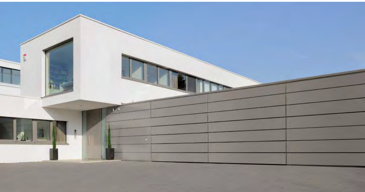
Bauseitige Beplankung mit Aluminium-Verbundplatten
