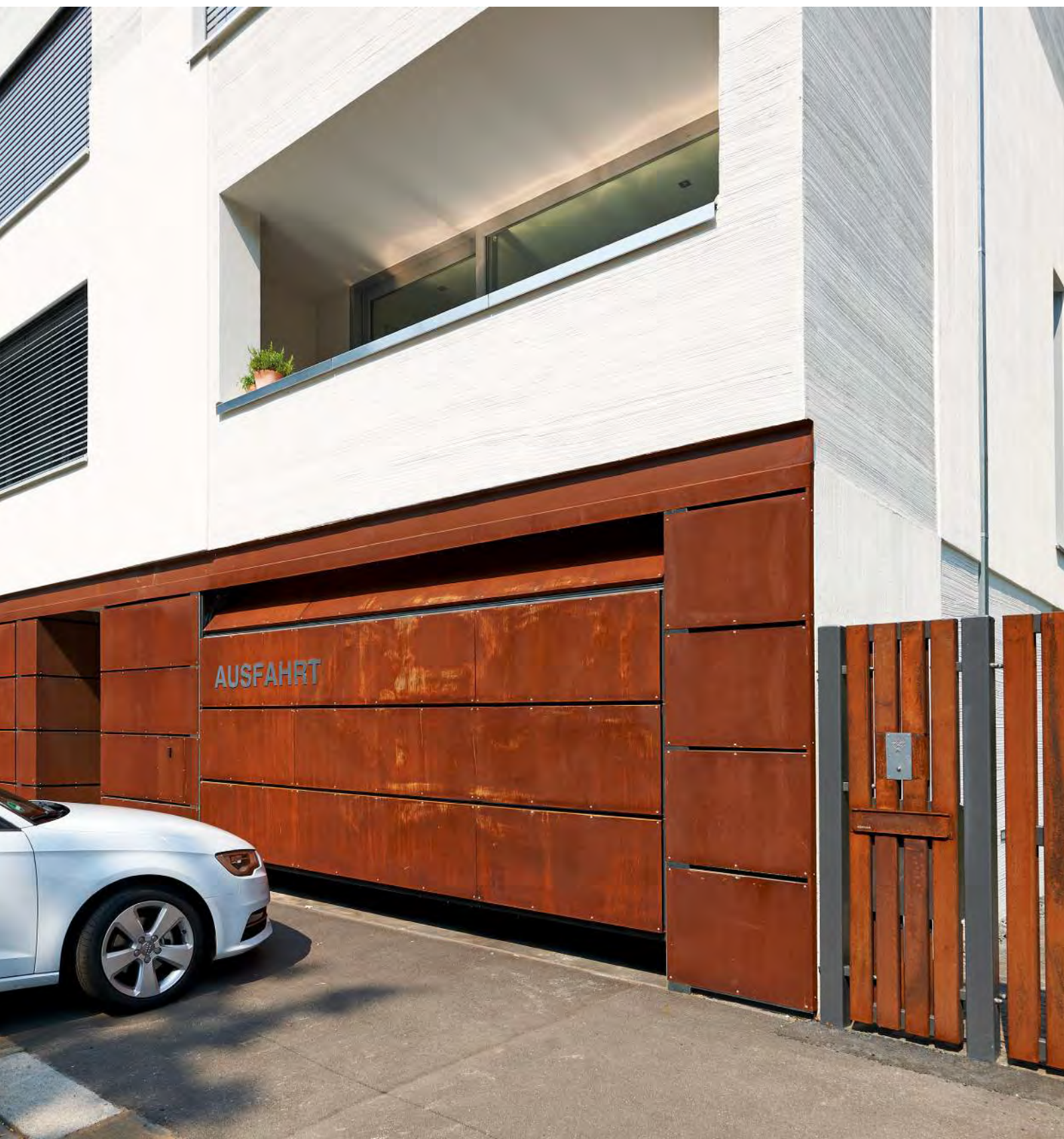
Bauseitige Beplankung mit Schichtpressplatten
